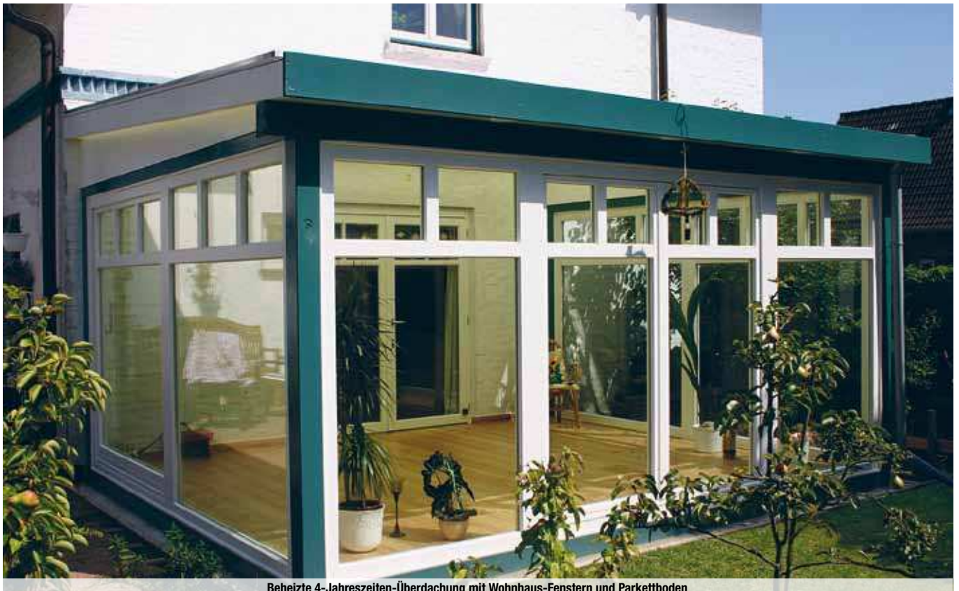
Beheizte 4-Jahreszeiten-Überdachung mit Wohnhaus-Fenstern und Parkettboden
