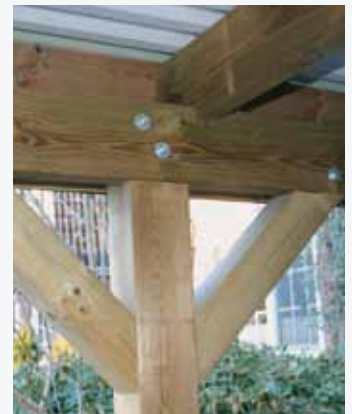
Massive Holzdimensionen, verbunden mit sturmfesten 2-Bolzen-System, optional Kopfbänder.
