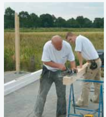
Auf Wunsch fachgerechter Montage-Service direkt vor Ort.
