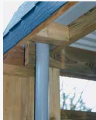
Immer 4-seitig umlaufende Blende mit verdeckt vormontierter Rinnenanlage.
